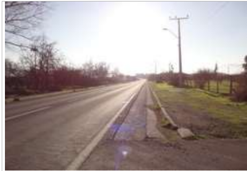
CAMINO DE ACCESO
